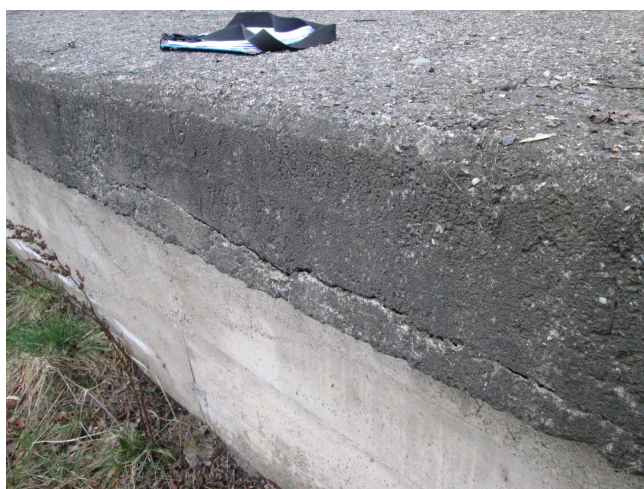
Separovaná krycí vrstva na ozubu římsy.
