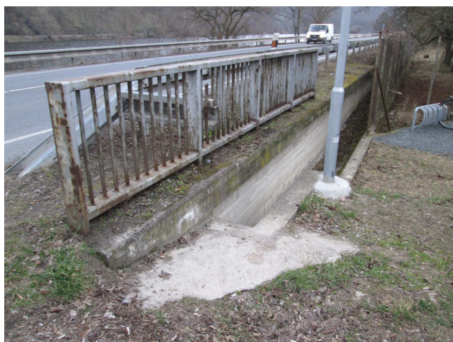
Koroze zábradlí.
